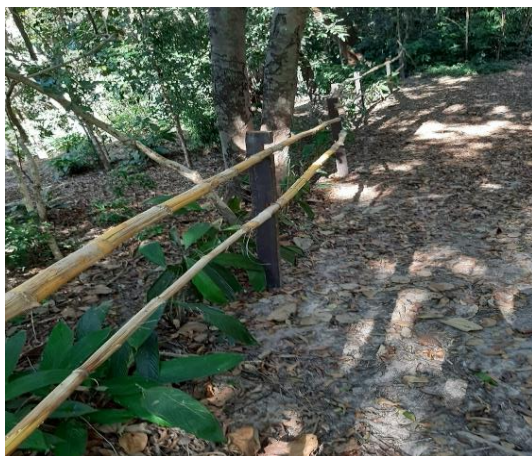
Foto 19 – Confeção de barreira com madeira e bambu para o isolamento das áreas que possam oferecer risco aos visitantes do parque Lajeado.
