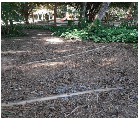
Foto 17 - Reformulação da trilha com a colocação de material triturado e bambu para diminuir o escoamento da água na trilha e consequentemente diminuir processo de erosão
