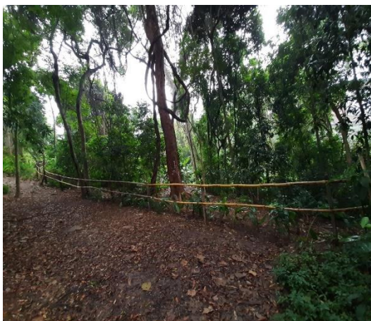
Foto 21 Confeção de barreira de madeira e bambu para o isolamento de áreas de declive que oferecem riscos aos visitantes
